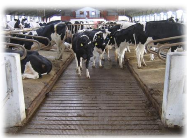
Figur 4. Rilleskåret gulv
