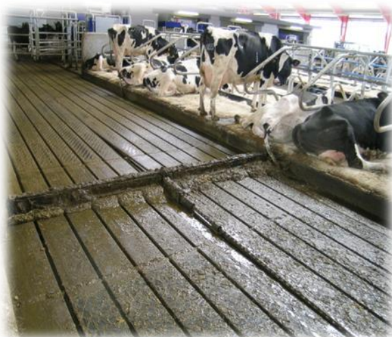
Figur 1. Indstøbt rilleprofileret gummibane giver god skridsikkerhed.
