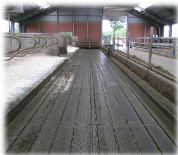
Figur 1. Indstøbt rilleprofileret gummibane giver god skridsikkerhed
