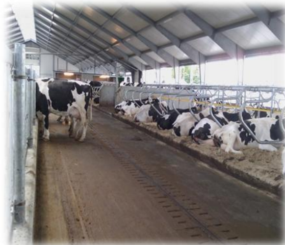
Figur 4. Fodergang med drænelement
