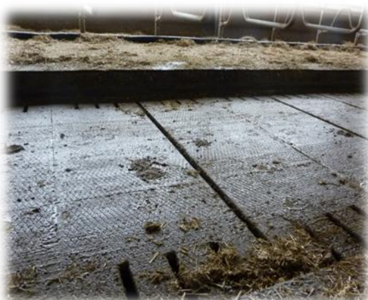
Figur 1. Elementer falder 1 pct. mod åbning Figur 2. Tørt gangareal
