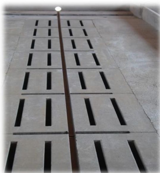
Figur 2. Kanalelementer lagt i serie
