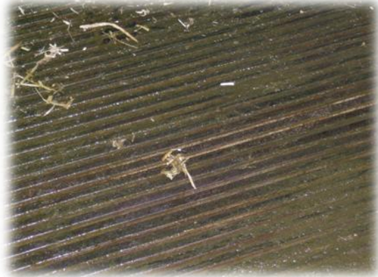
Figur 4. God rilleskæring af plant gulv
