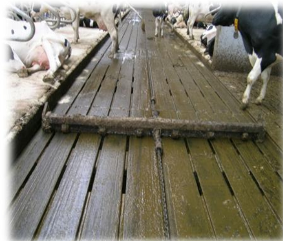
Figur 2. Langsgående afleveringsriller
