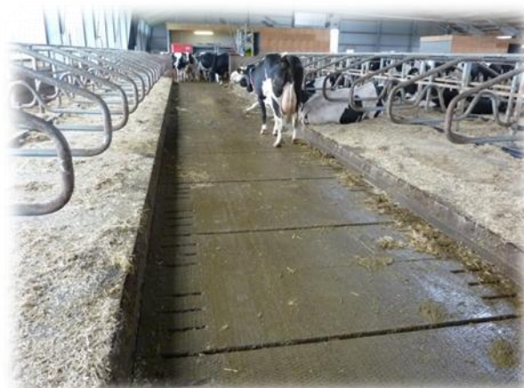
Figur 1. Elementer falder 1 pct. mod åbning Figur 2. Tørt gangareal
