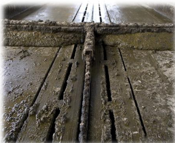
Figur 1. Kanalelementet bortleder gødningen
