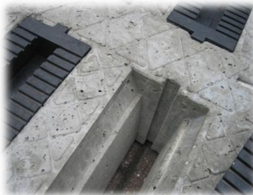
Figur 2. Gummiindsats kan udskiftes
