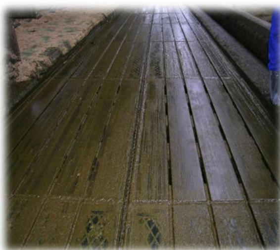
Figur 2. Langsgående afleveringsriller
